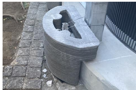
図 2: 3D プリンターで作成した型枠
